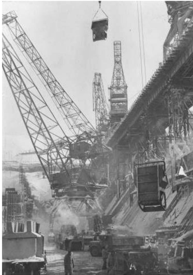
Рис.6.3. Укладка бетона в тело плотины.
