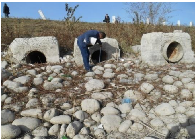
Рис.6. Аварийные водосбросы трубчатые, вид с верхнего бьефа.
