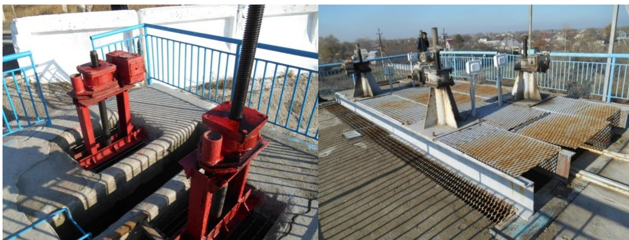
Рис.8. Механизмы подъема плоских затворов
