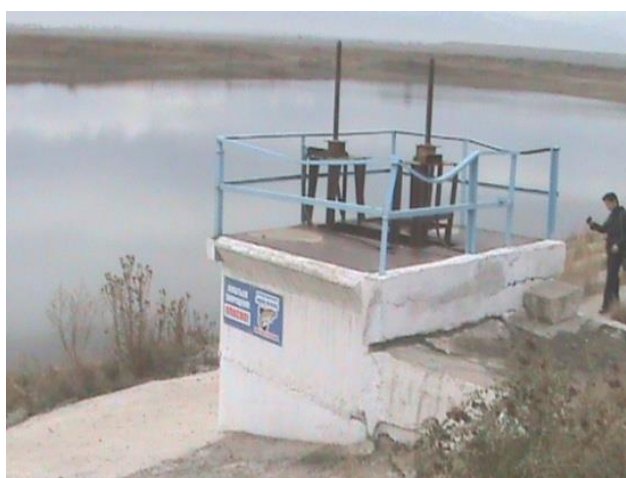
Рис.3. Глубинные затворы шахтных водосбросов, с разным количеством затворов.
