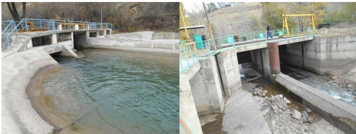
Рис. 4. Большие гидроузлы. Особенностью их является пропуск большого объема воды, сложность управления, значительные эксплуатационные расходы.
