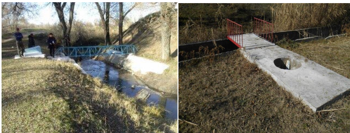
Рис.9. Гидрометрический пост с мостиком и колодцем.
