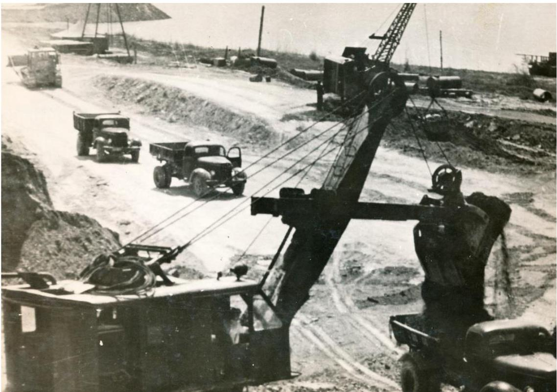
Рис.4.Транспортировка грунта при строительстве плотины.
