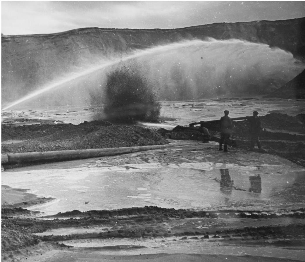
Рис.7. Разработка песка средствами гидромеханизации.
