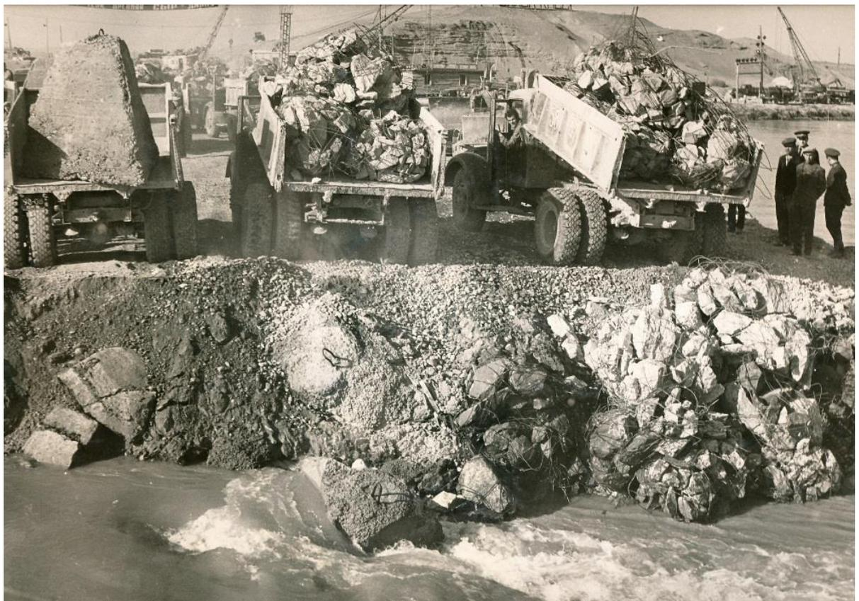
Рис.6.Отсыпка упорной призмы Шардаринской плотины.
