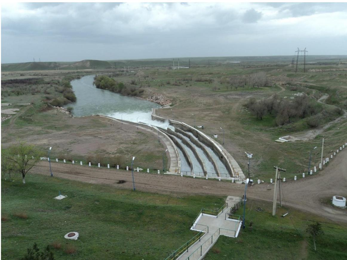
Рис.10.1. Сбросное сооружение плотины.
