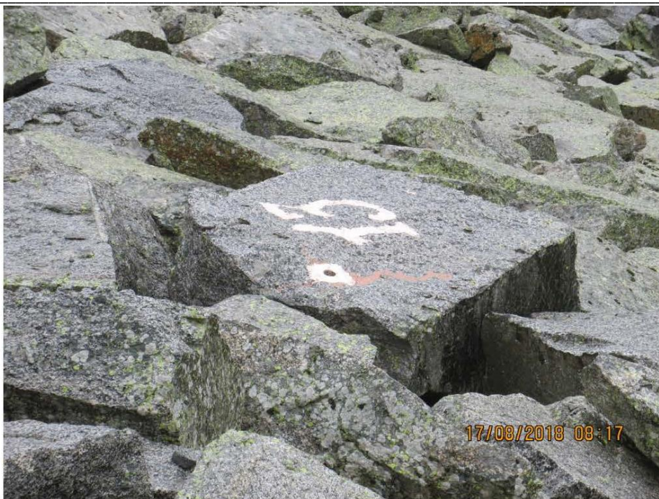
Рис.4. Каменно набросная плотина. Геодезические марки, для контроля за осадками на нижнем откосе плотины.
