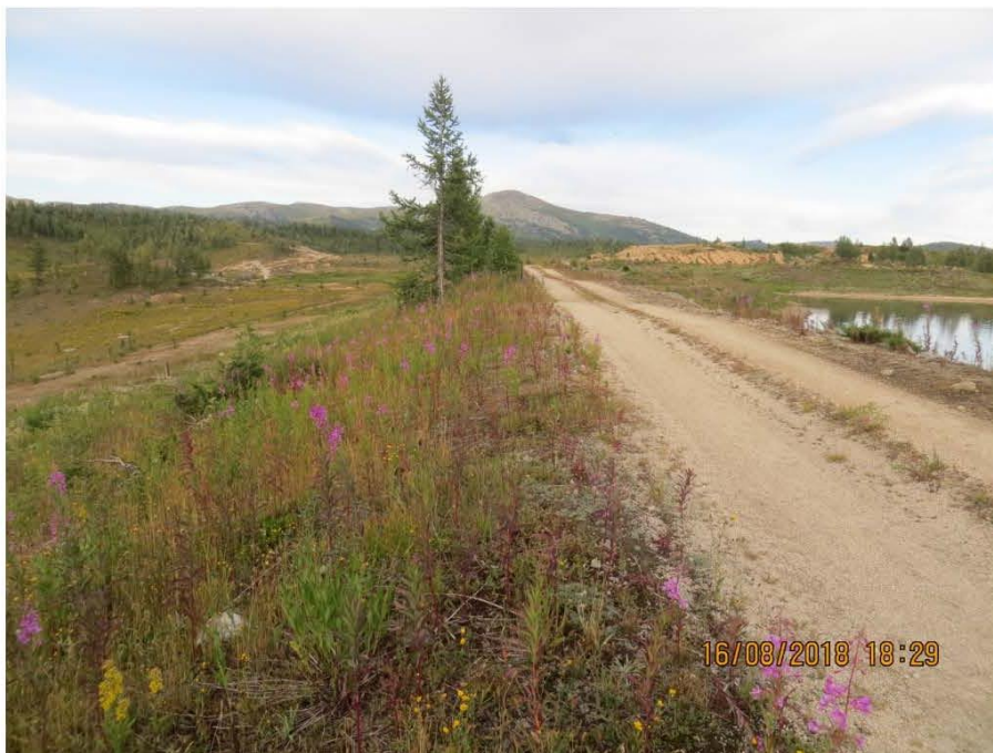
Рис.10. Плотина №2. Гребень плотины и низовой откос с посевами трав на откосе.
