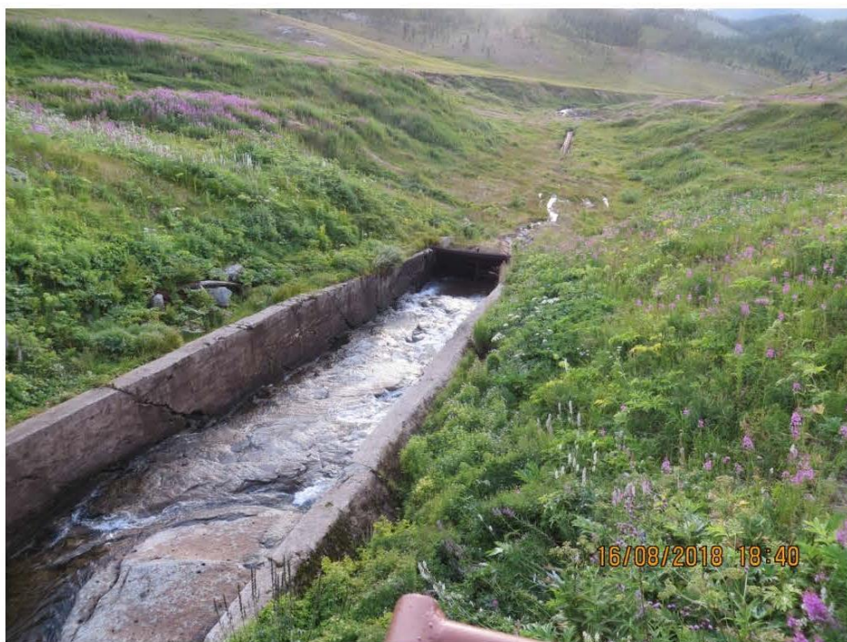
Рис.13. Водосбросной лоток рабочего водовыпуска.
