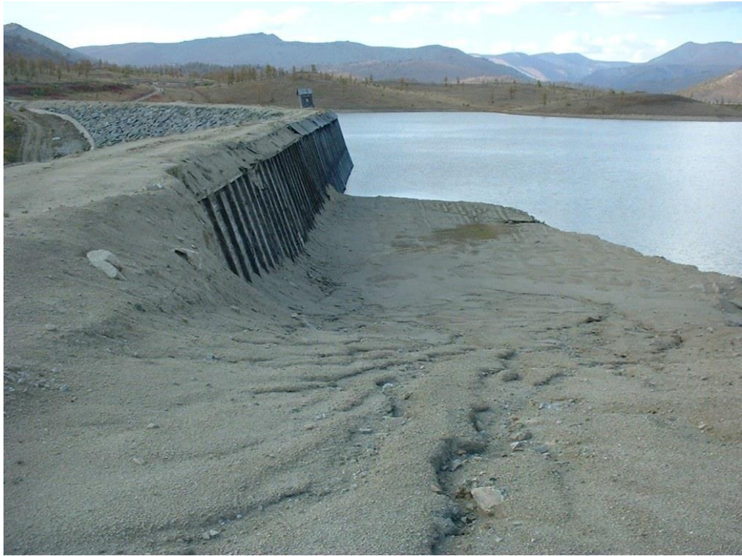
Рис.10.2. Вид на каменно-набросную плотину водохранилища.
