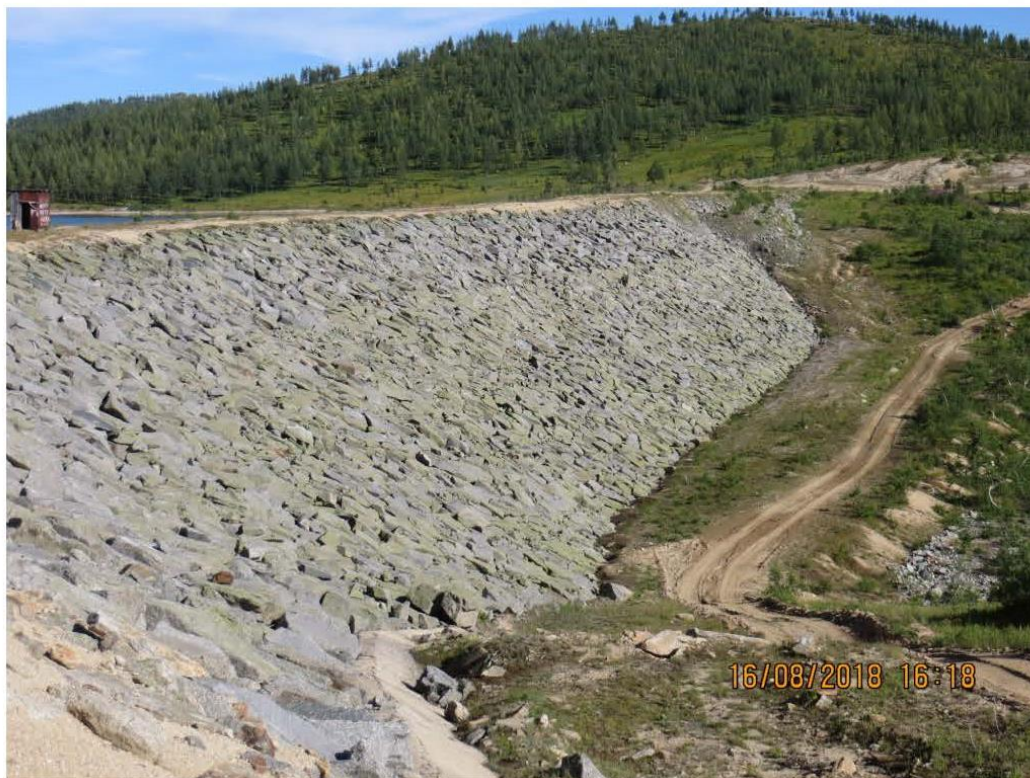
Рис.1. Каменно набросная плотина. Нижний бьеф.
