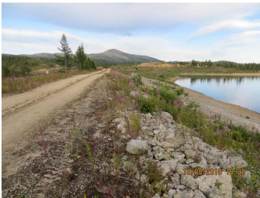
Рис.9. Плотина №2. Гребень плотины и верховой откос, каменное крепление.
