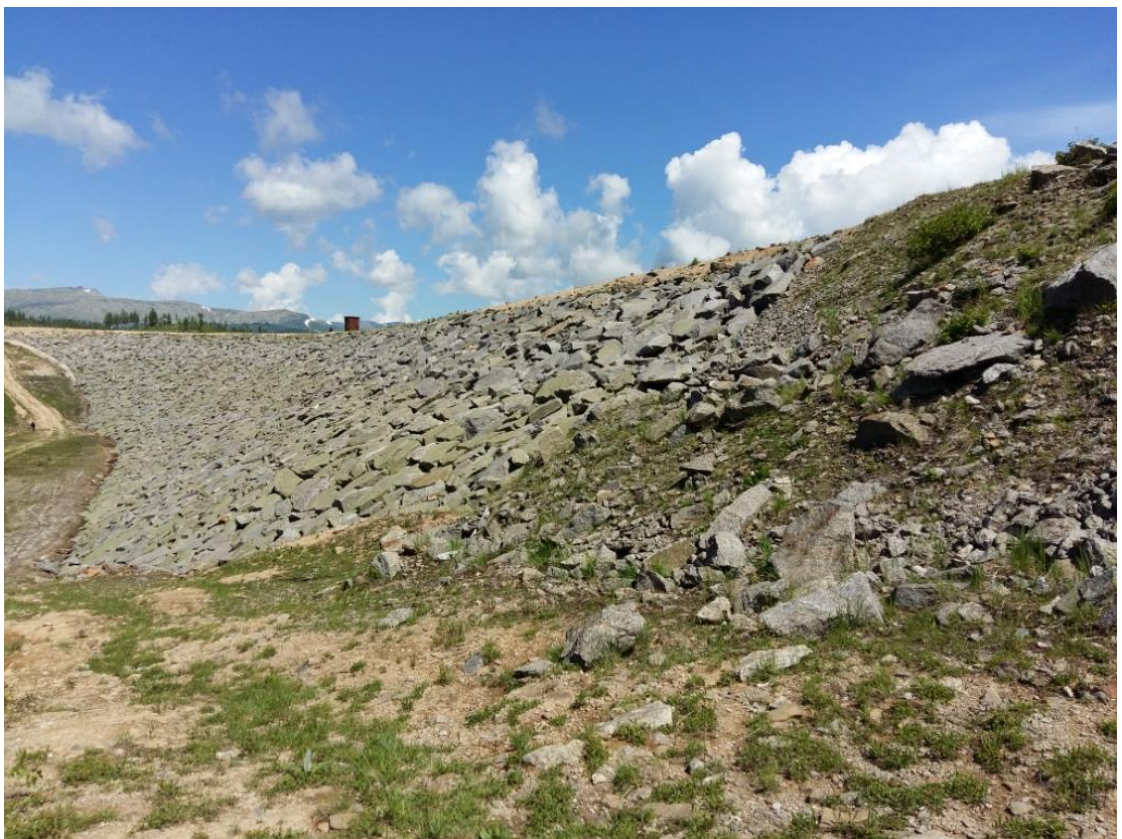
Рис.10.5. Вид нижнего бьефа каменно-набросной плотины.
