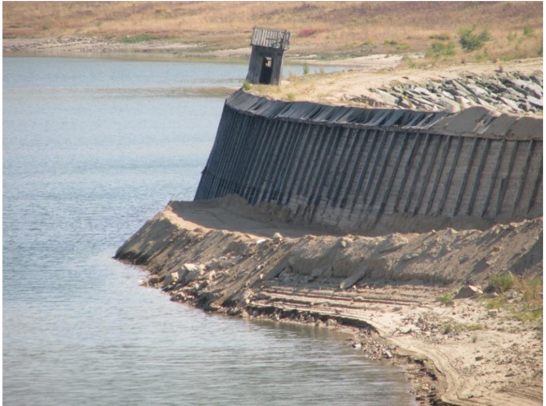
Рис.10.4. Вид на каменно-набросную плотину водохранилища.
