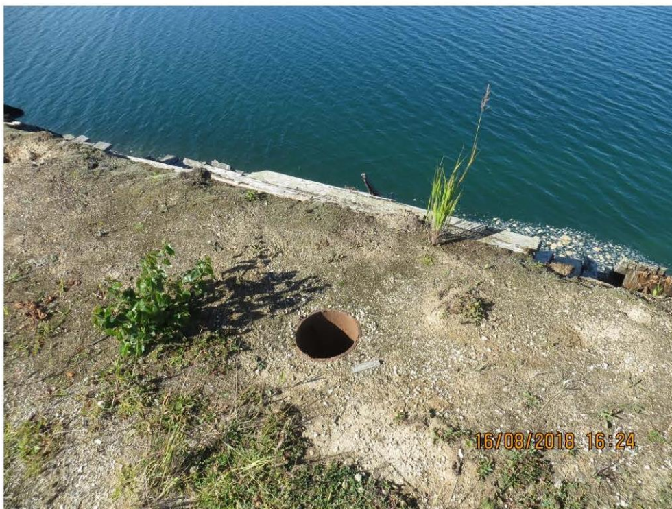
Рис.6. Геодезические марки на гребне каменно набросной плотины.
