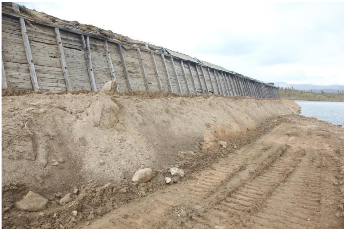
Рис.10.3. Вид на каменно-набросную плотину водохранилища.
