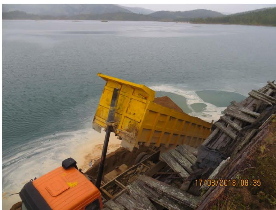
Рис.17. Проведение работ по реконструкции каменно-набросной плотины. Отсыпка верхового откоса.
