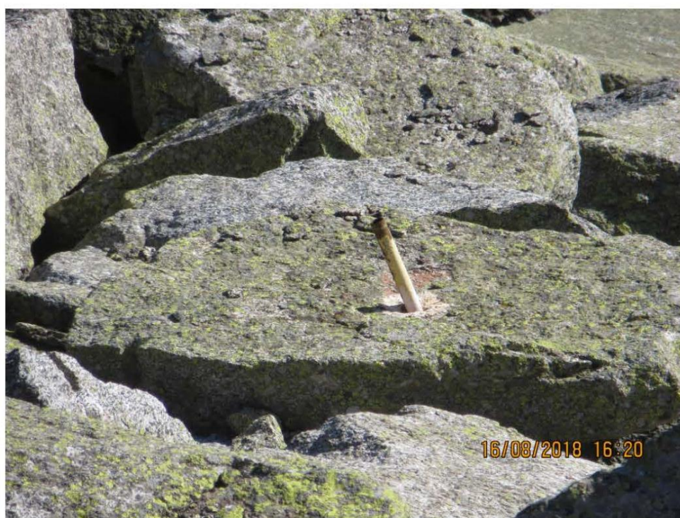
Рис.5. Каменно набросная плотина. Геодезические марки, для контроля за осадками на нижнем откосе плотины.
