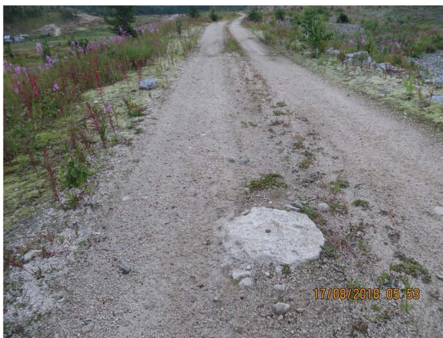
Рис.11. Геодезические марки на гребне плотины №1.
