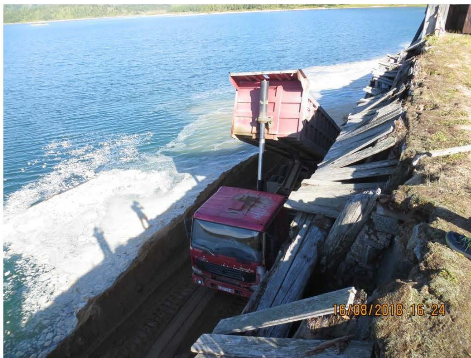
Рис.16. Проведение работ по реконструкции каменно-набросной плотины. Отсыпка верхового откоса.
