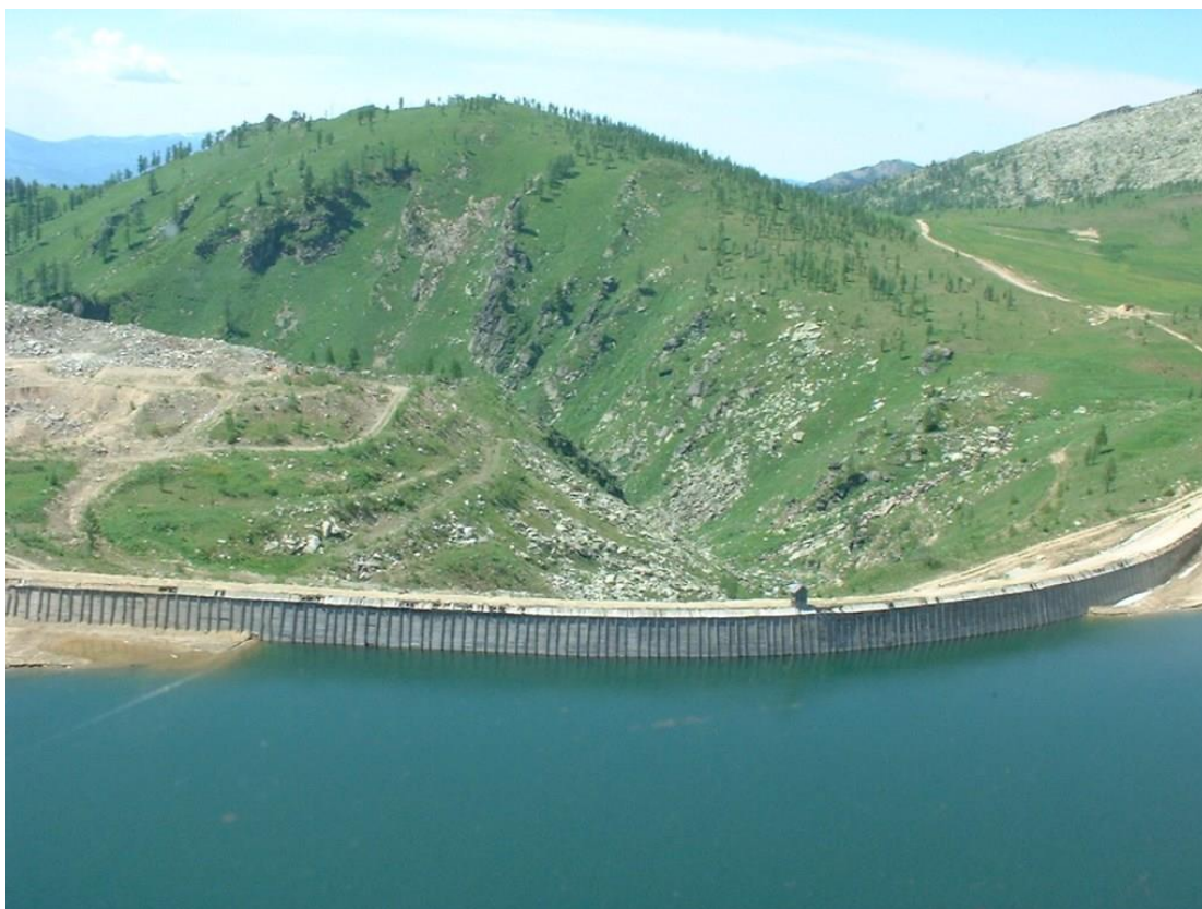
Рис.10.1. Вид на каменно-набросную плотину водохранилища.
