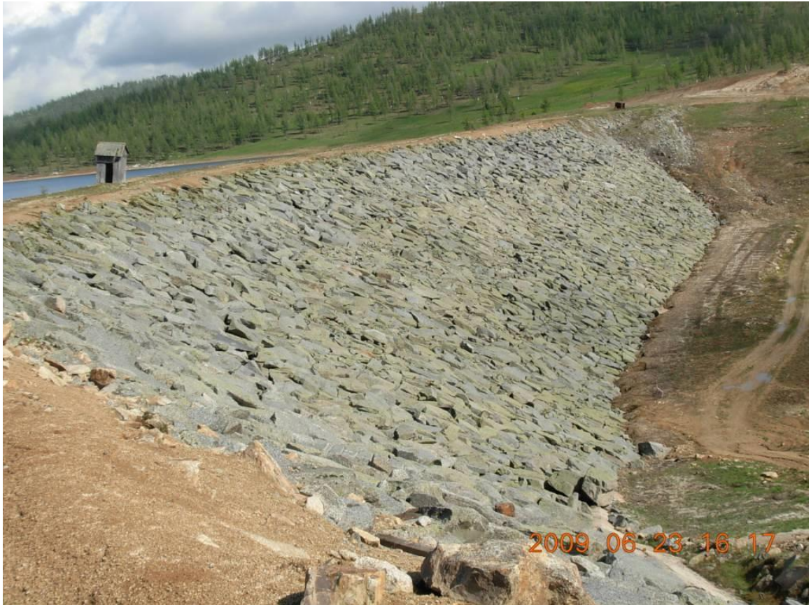
Рис.10.6. Вид нижнего бьефа каменно-набросной плотины.
