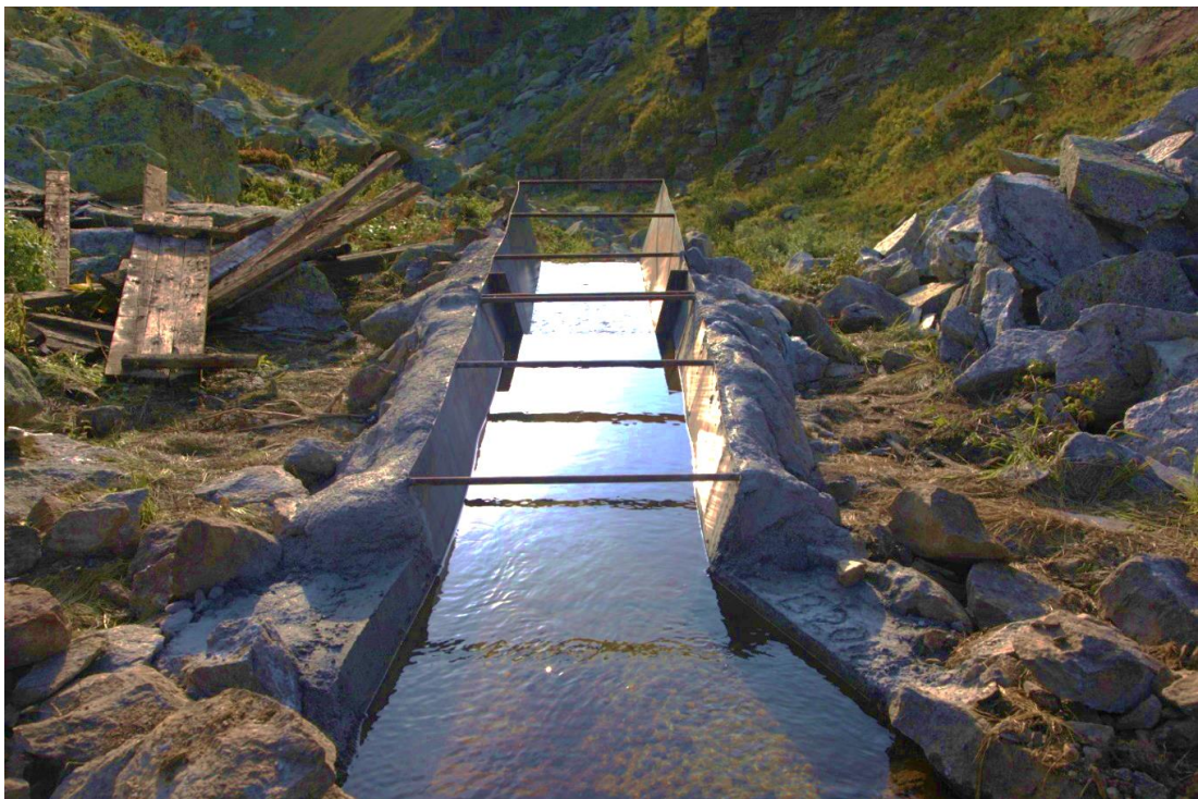
Рис.10.7. Водомерный лоток ВЧ-75 на каменно-набросной плотине. Нижний бьеф.
