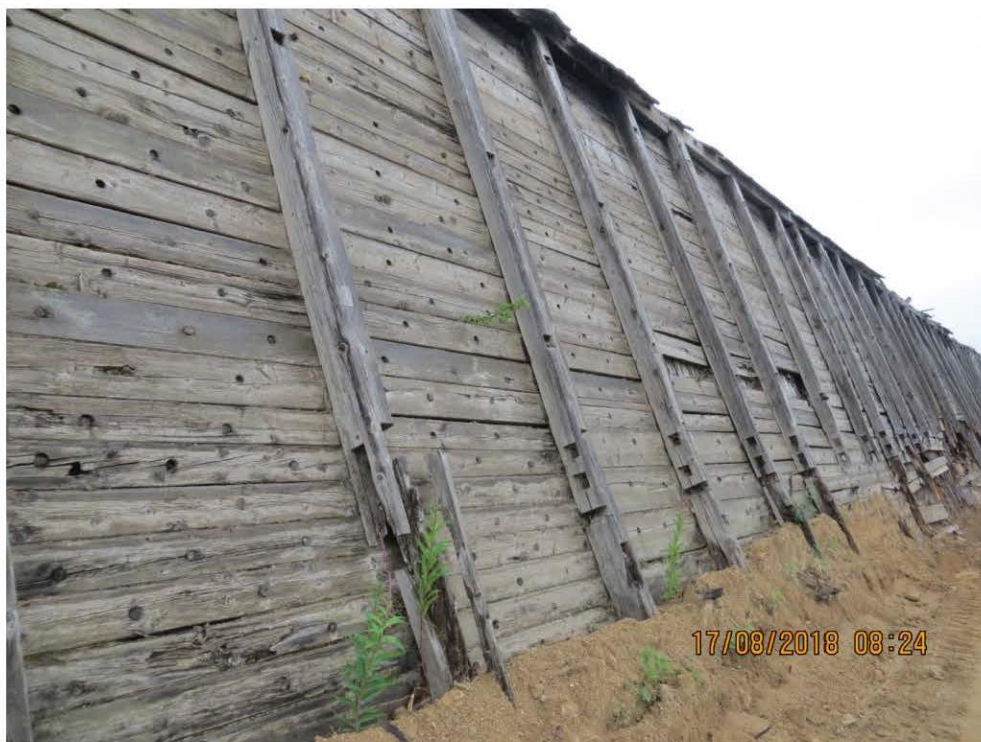
Рис.2. Каменная набросная плотина. Верхний бьеф. Крепление деревянными щитами 3 слоя.
