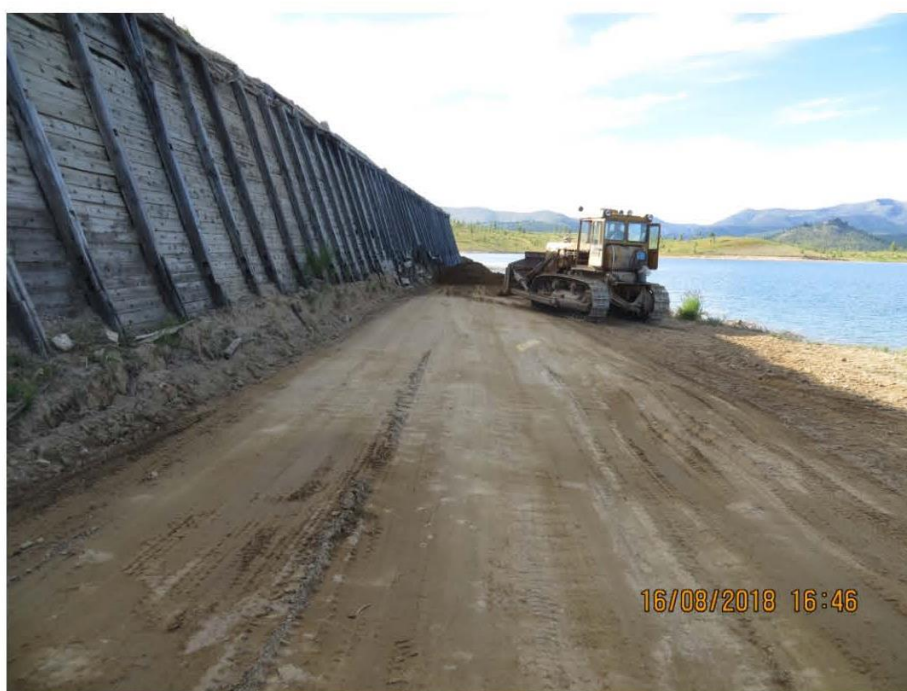
Рис.15. Проведение работ по реконструкции каменно-набросной плотины. Отсыпка верхового откоса.
