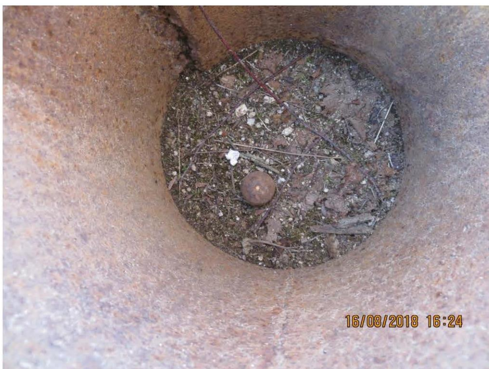
Рис.7. Геодезические марки на гребне каменно набросной плотины.
