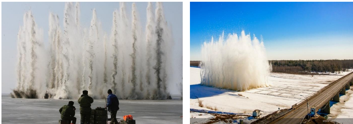
Рис.11.3. Взрывные способы разрушения льда.
