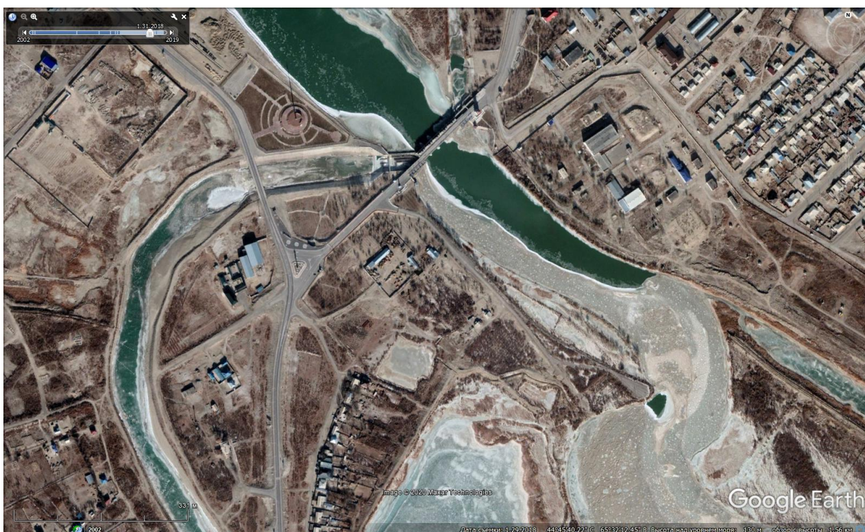
Рис.7.8. Ледовые явления на Кызылординском гидроузле.
