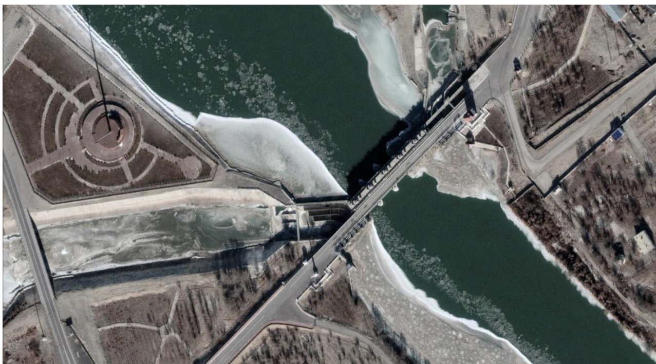
Рис.7.10. Ледовые явления на Кызылординском гидроузле.
