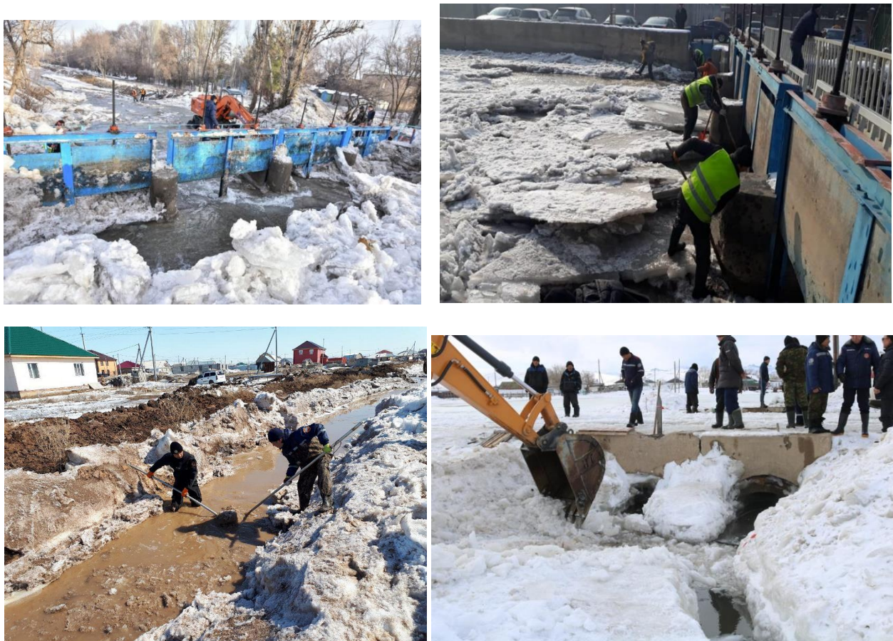
Рис.11.2. Очистка гидроузлов от льда.
