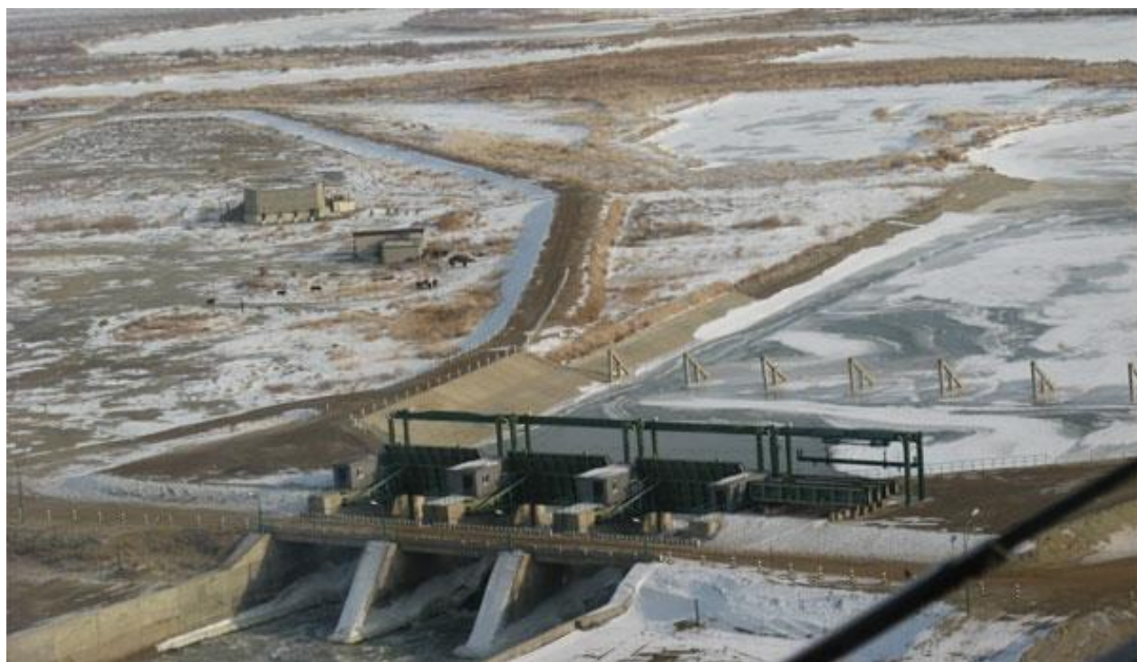
Рис.7.18. Ледовые явления на Аклакском гидроузле.
