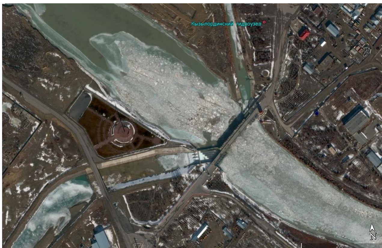
Рис.7.12. Ледовые явления на Кызылординском гидроузле.
