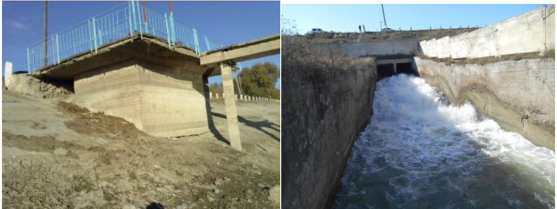
Рис.2. Вид на шахтные водосбросные сооружения в верхнем и нижнем бьефе плотины.
