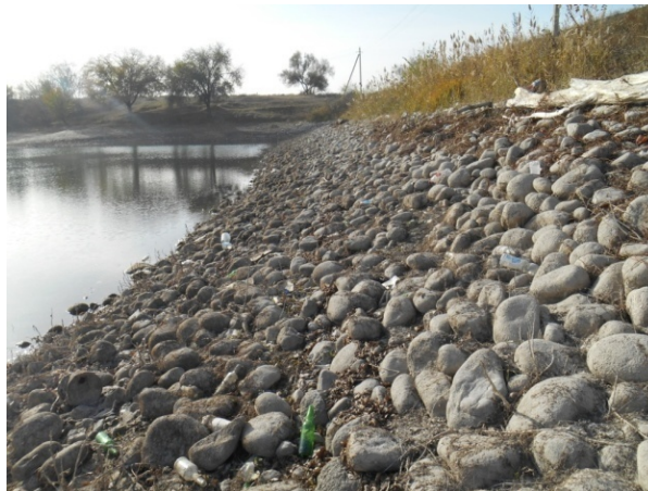
Рис.1. Плотины каменным креплением откосов.
