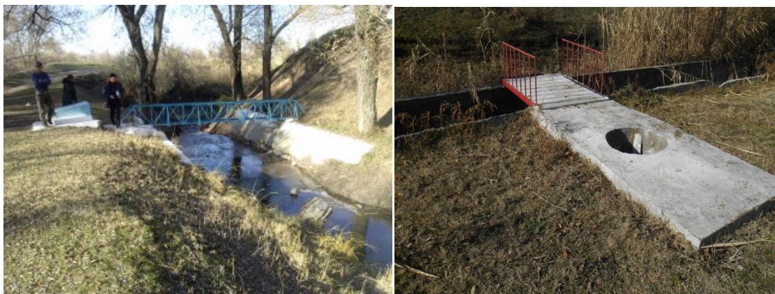
Рис.9. Гидрометрический пост с мостиком и колодцем.
