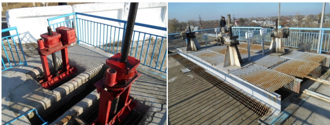
Рис.8. Механизмы подъема плоских затворов
