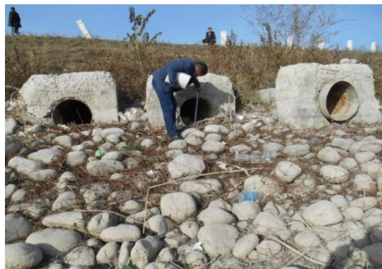
Рис.6. Аварийные водосбросы трубчатые, вид с верхнего бьефа.
