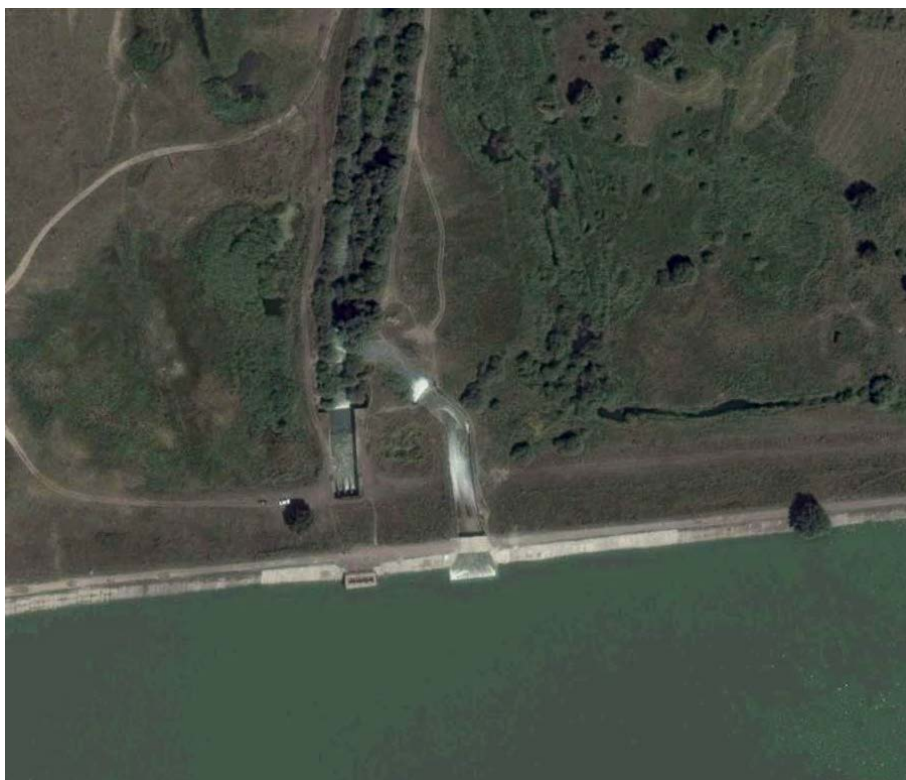
Рис.3.2. Таранское водохранилище в Алматинской области. 2014 г. Аварийный водосброс построен.
