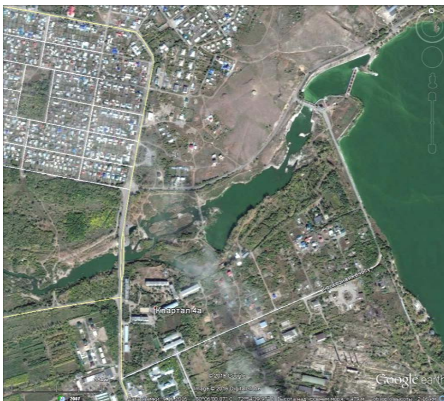
Рис.3.4. Самаркандское водохранилище в Карагандинской области. Аварийного водосброса нет.
