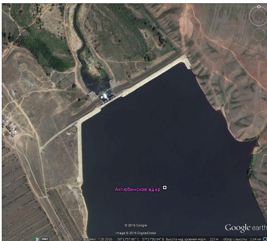
Рис. 3.6. Актыбинское водохранилище в Актыбинской области. Аварийного водосброса нет.
