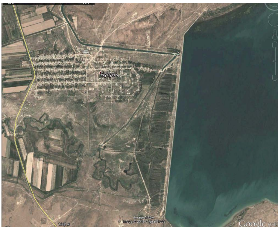
Рис.3.7. Бугуньское водохранилище в ЮКО. Аварийного водосброса нет.
