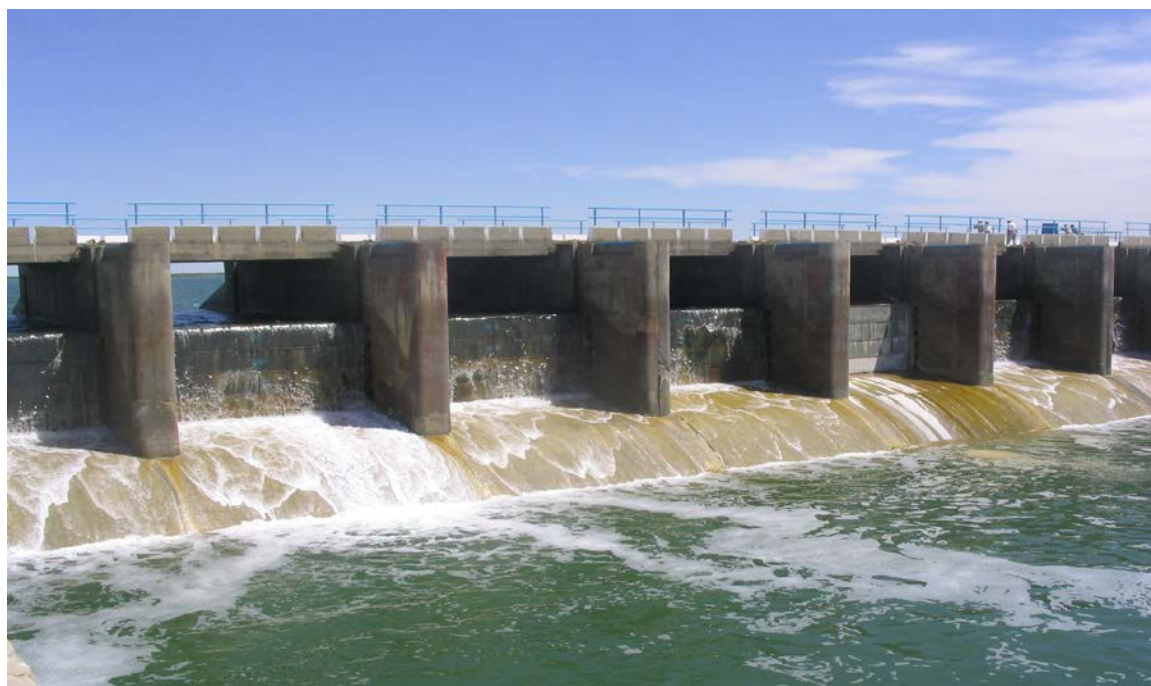
Рис.П2. Водосбросное сооружение на плотине САМ.
