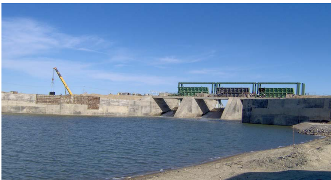
Рис.П4. Основное сооружение Аклак (вид с верхнего бьефа)
