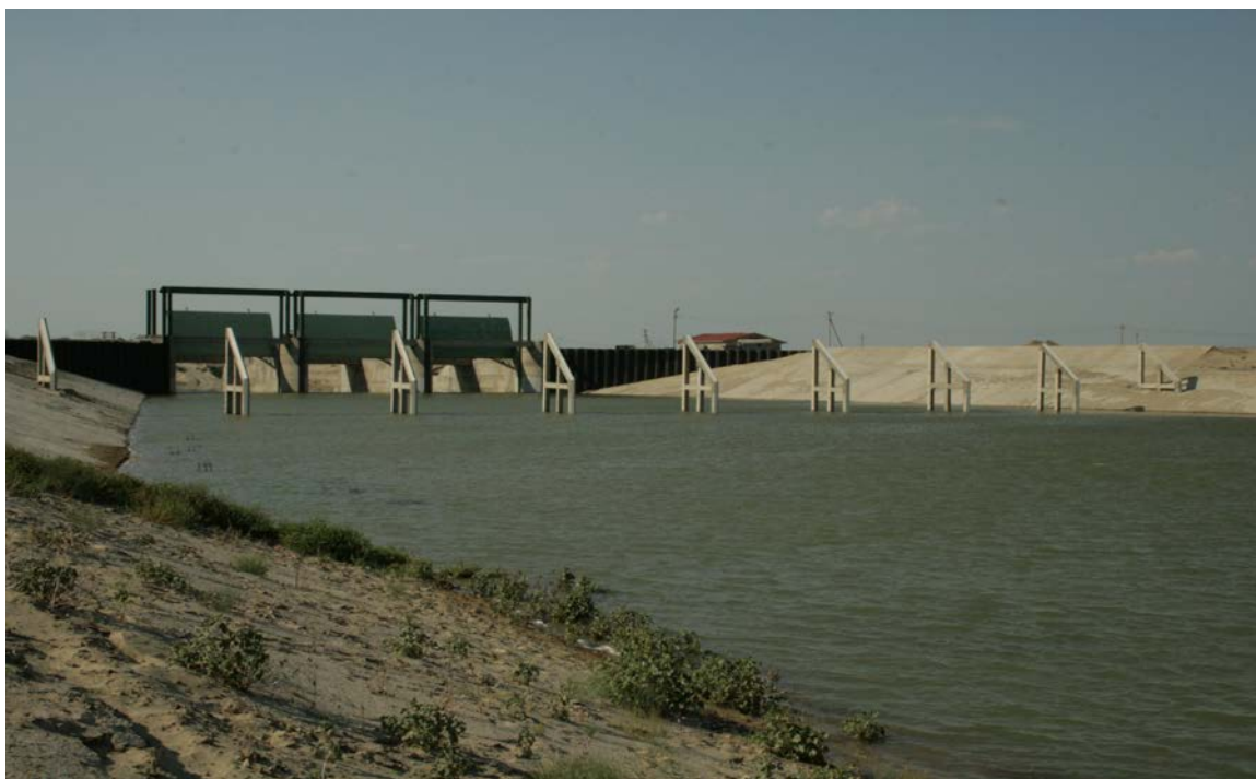
Рис.П5. Основное сооружение Аклак (вид с верхнего бьефа)
