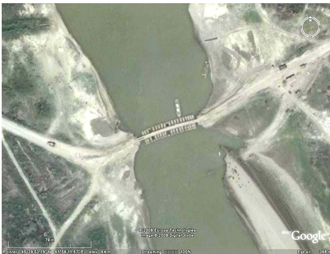
Рис. П11. Космоснимок существующей пантонной переправы на реке Сырдарья.
