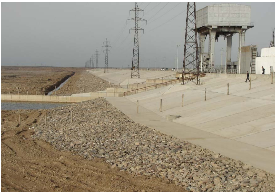
Рис.П6. Арнасайская плотина (нижний бьеф).
