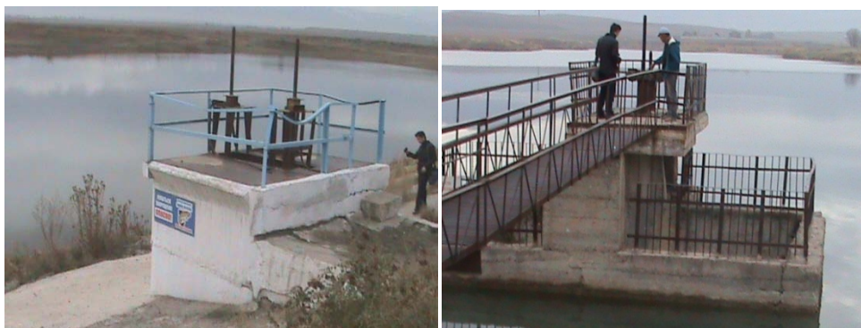
Рис.3. Глубинные затворы шахтных водосборов, с разным количеством затворов.
