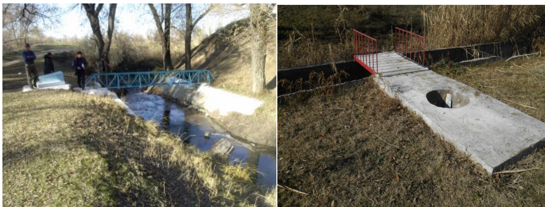
Рис.10. Гидрометрический пост с мостиком и колодцем.
